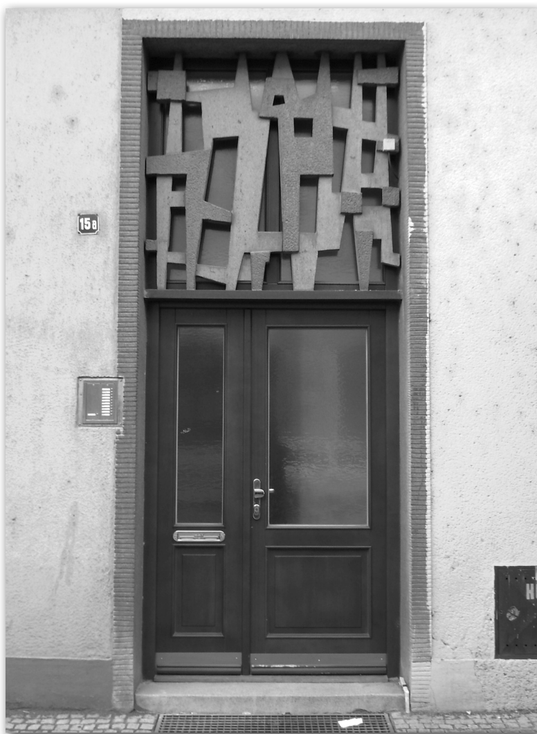
„Bruksela” komunalna: Opawa, żelbetowa krata nad wejściem do bloku mieszkalnego
